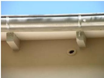
Es empfiehlt sich, die Einbausteine im Kaltdach- oder Drempelbereich einzubauen, um Wärmebrücken zu vermeiden. Wenn möglich, sollten die Niststeine mit einer **Hinterdämmung** z. B. mit höherwertigem Dämmmaterial versehen werden (Abbildungen).
