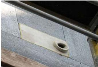
1. bündige Platzierung der Niststeine oder Quartiere in der Fassade oder dem WDVS mit Öffnung für Mauersegler seitlich (Foto), sowie Spalt für Fledermausquartier
